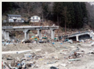
津波により壊滅した旧島越駅付近。駅名の「カルボナード」由来の説明破壊された鉄道架橋が襲来した津波の威力の大きさを物語る。
