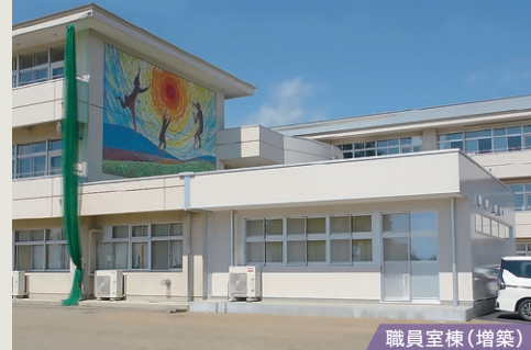
職員室棟(増築)
