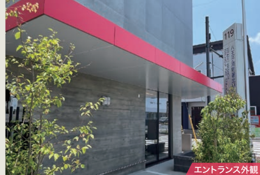
エントランス外観
