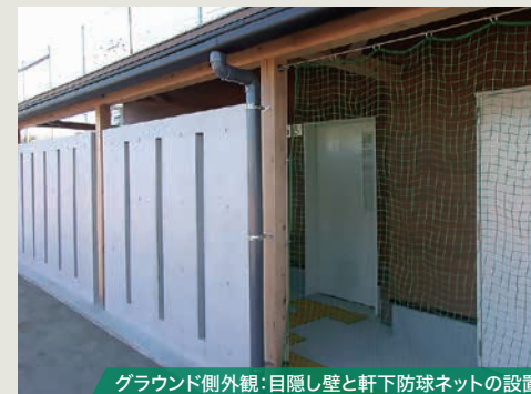
グラウンド側外観:目隠し壁と軒下防球ネットの設置
