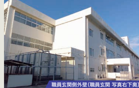
職員玄関側外壁(職員玄関 写真右下奥)
