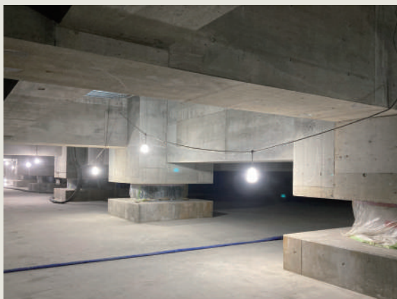
錫プラグ積層ゴム、積層(天然)ゴム、転がり支承を組み合わせたハイブリッド免震装置
