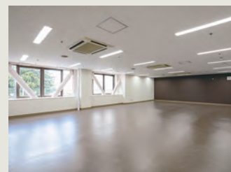
耐震性能と内観へ配慮した会議室（本館）
