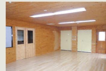
全面的な床の張替をした中塗り・下塗り室。床暖房の熱による影響を受けにくいカバ材を利用しました。
