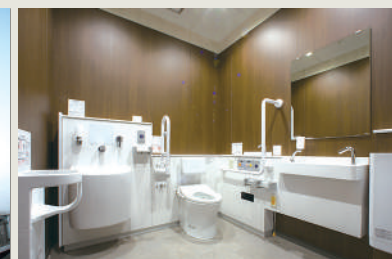
オストメイト機能等を完備している多機能トイレ
