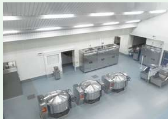
2階見学通路よりみる調理場
