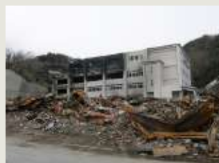
火災を受けた小学校
