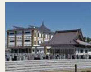
太陽光発電設備
