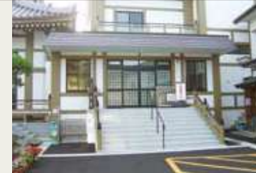
玄関(車椅子昇降機や融雪ヒーターを設置)
