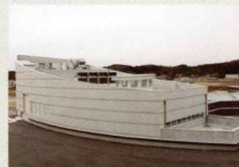
火葬炉棟の集じん装置
