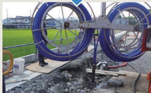
埋設場所：駐車場兼ヘリポート／アスファルト舗装下 ダブルUチューブ100m×120本設置
