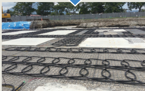
埋設場所：病棟／建物下 地上面より2m下に設置 長さ約5,000m
