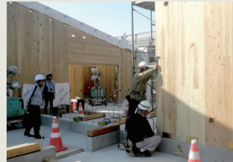
CLTパネルを設置する様子
