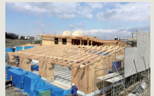
張弦梁を設置する様子
