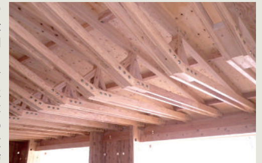
LVLを使用した張弦梁構造の下弦材
