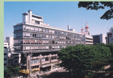
当時、最先端の複合ビルとして竣工した二代目岩手教育会館
