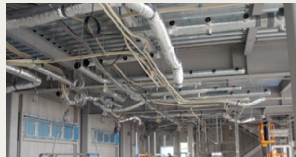
天井放射冷暖房システムの工事の様子
