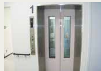
新設エレベータと手摺
