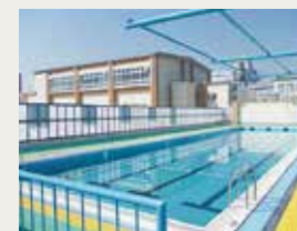
高耐久性フッ素樹脂塗料で塗り直したステンレス槽屋上プール
